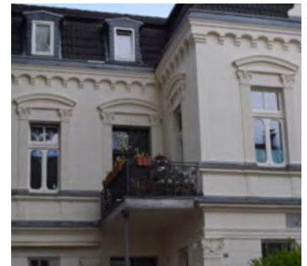
Abbildung 19 Erhaltenes Fassadenbild aus der Zeit des Klassizismus
