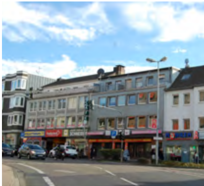
Abbildung 8 Straßenrandbebauung an der Kölner Straße, Kreisstadt Bergheim
