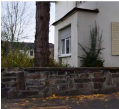
Abbildung 77 Natursteinmauer mit Natursteinabdeckung
