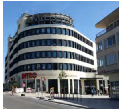
Abbildung 9 Neues Einkaufszentrum an der Kölner Straße, Kreisstadt Bergheim
