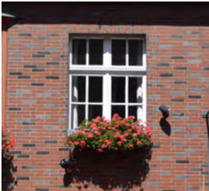
Abbildung 44 Fenster mit Sprossen und Oberlicht
