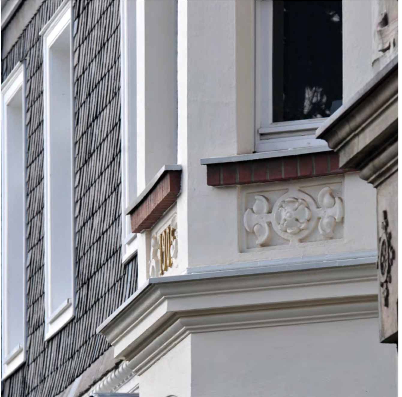
Abbildung 36 Fassadenelemente und Auskragungen
