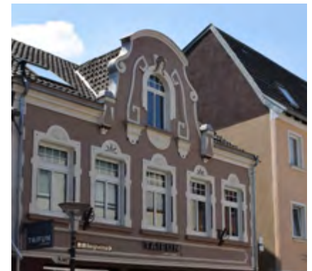
Abbildung 29 Sanierte Fassadenansicht mit Werbeanlagen
